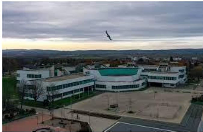
Schulhof der Hauptschule mit Fußballplatz und Basketballfeld
