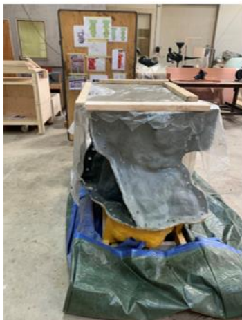
Die Form mit Beton gefüllt
